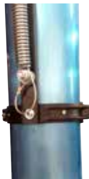
Cavo di sicurezza interno alle molle Springs with internal safety cable
