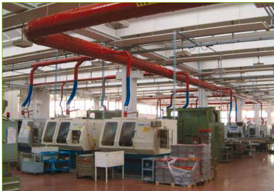
Impianto di captazione nebbie d'olio in una azienda di produzione minuteria metalliche per il settore automobilistico
