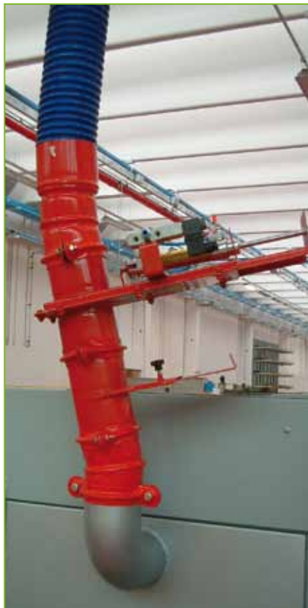
Preso aspirante con serranda di regolazione, serranda on/off elettropneumatica e bicchiere anti-olio
