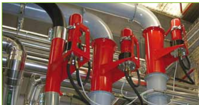
Compartimentazione delle tubazioni
