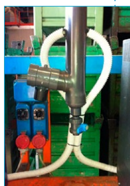
Calata a muro e raccordi alla batteria
